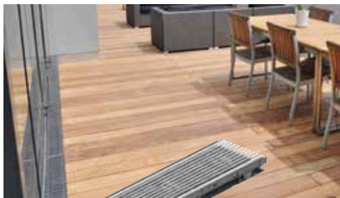
Rinnenkörper aus glasfaserverstärktem Polypropylen
